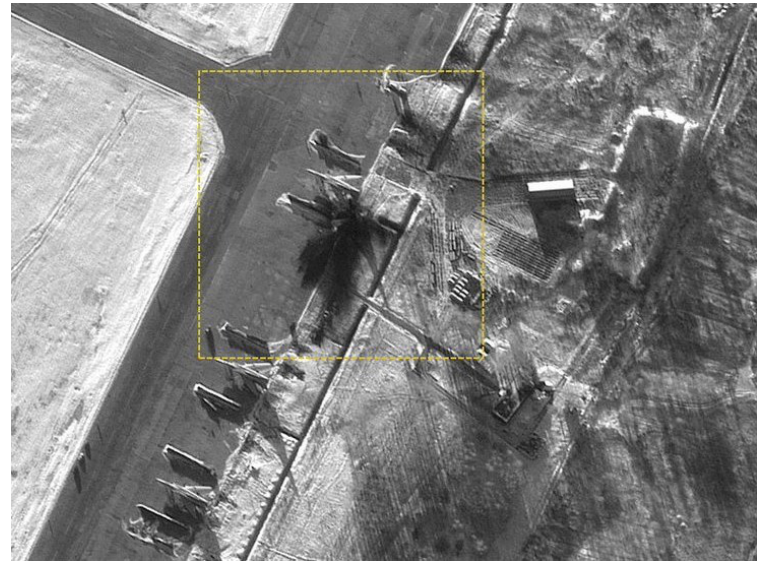
Schäden am Flugplatz in Rjasan.
