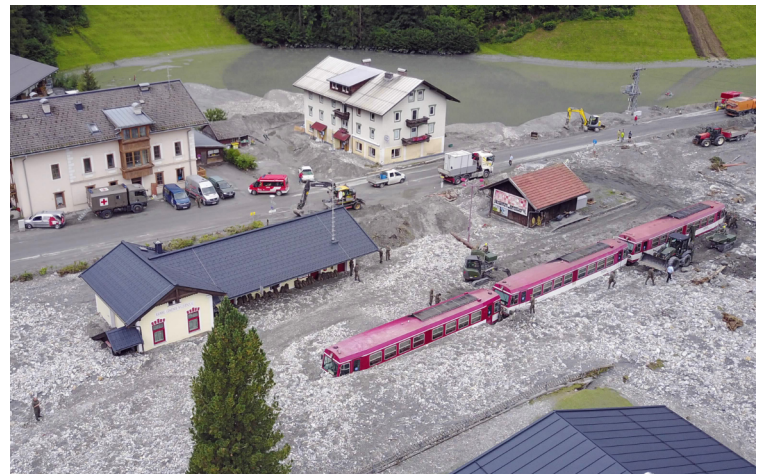
Der gesamte Bahnhofsbereich mitsamt eines Zuges wurde von einer Mure verschüttet.
