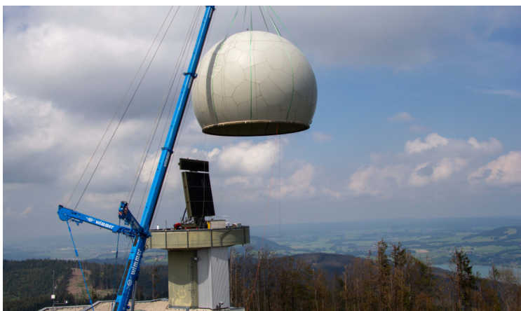
Vorsichtig wird die Radarkuppel über das Radar gehoben
