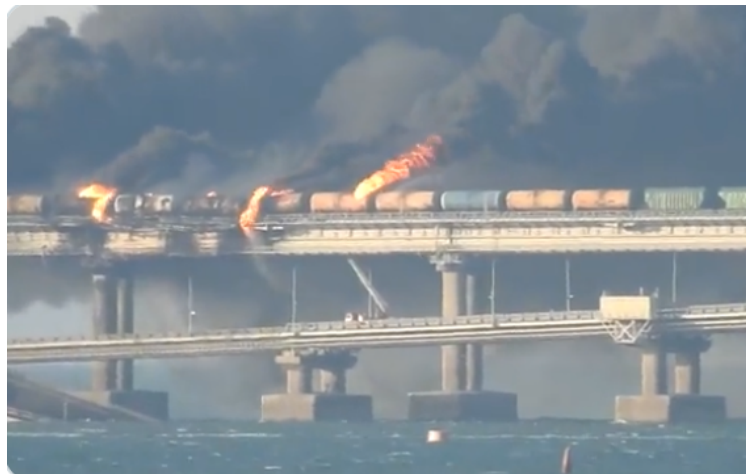
Brücke von Kertsch: Tankzug in Brand
